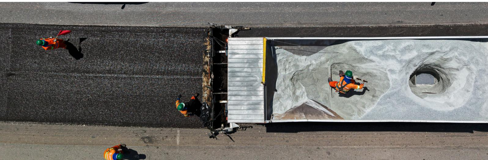
Iniciamos uma nova etapa das obras de pavimentação, com substituição da camada asfáltica atual por uma nova. Desta forma:
